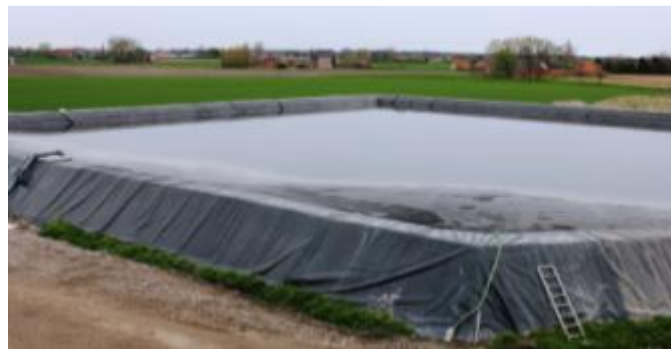
Figuur 4: Effluentbekken met folie over buitentalud.
